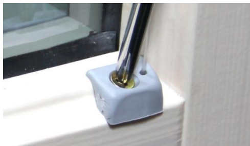
c) Plasser beslag helt inn til hjørnet av ramme og forbor inn 5mm med et 2mm bor i 15°. Tynn syl kan også brukes.
