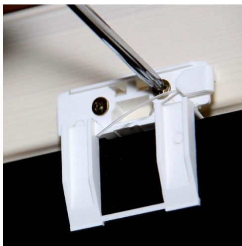
b) Plasser persienne i toppen og forbor med et 2mm bor eller bruk tynn syl. Fest persienne med 2 skruer i rammen på begge sider.
